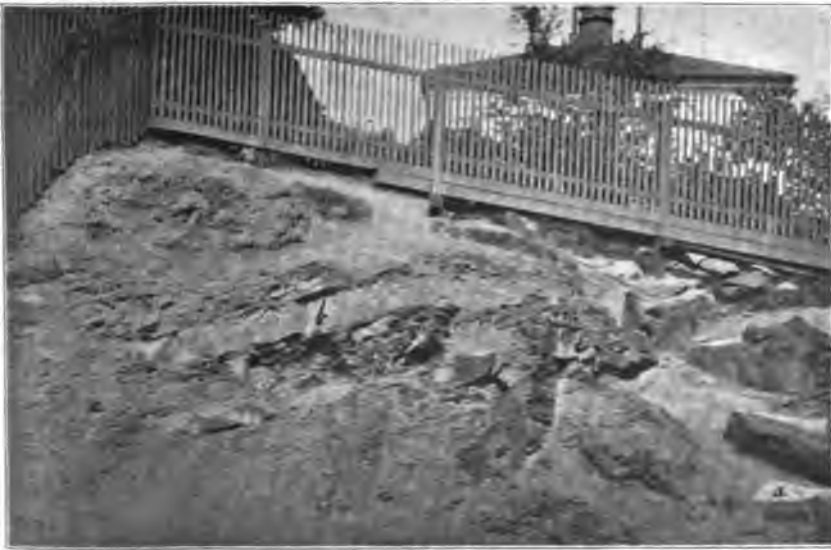
Etage 3 a α paa hjørnet af Sofienberggaden og Trondhjemsveien.
